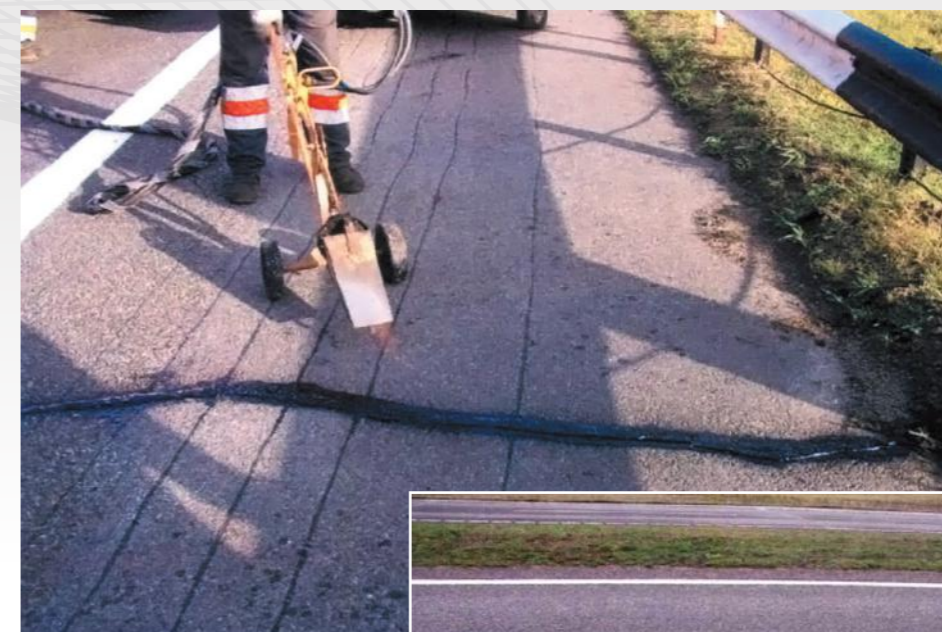
Дополнительное прогревание ленточного материала
