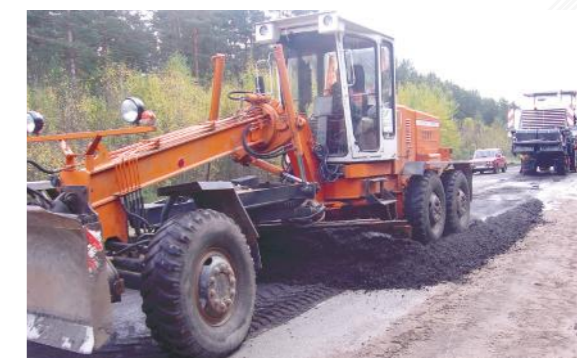
Профилированное распределение смеси
