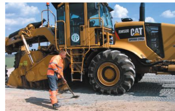
Смешение грунта с цементом и добавкой «Nicoflok»
