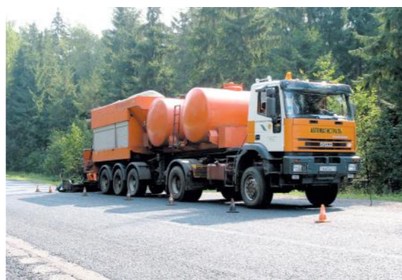
Устройство защитных слоев «Сларри Сил»
