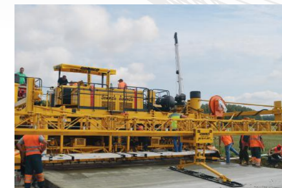
Окончательное распределение и «выглаживание» бетона
