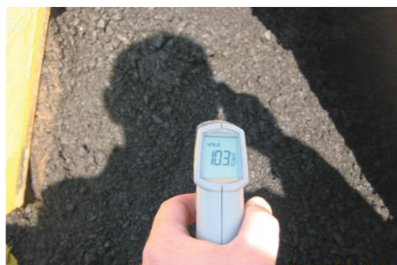
Укладка низкотемпературной асфальтобетонной смеси
