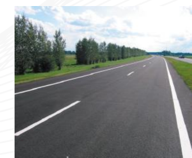
Вид готового покрытия
