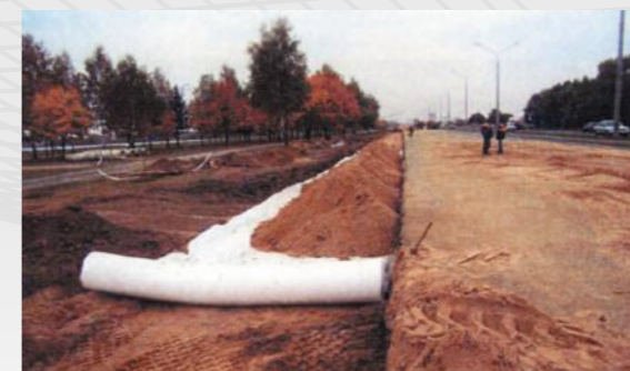
Отсыпка песчаного дренажного слоя на уширении дорожной одежды (пр. Победителей, г. Минск)
