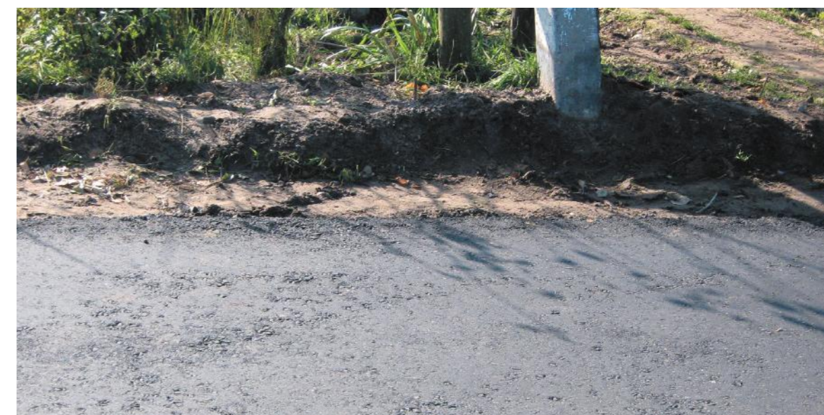
Вид готового покрытия
