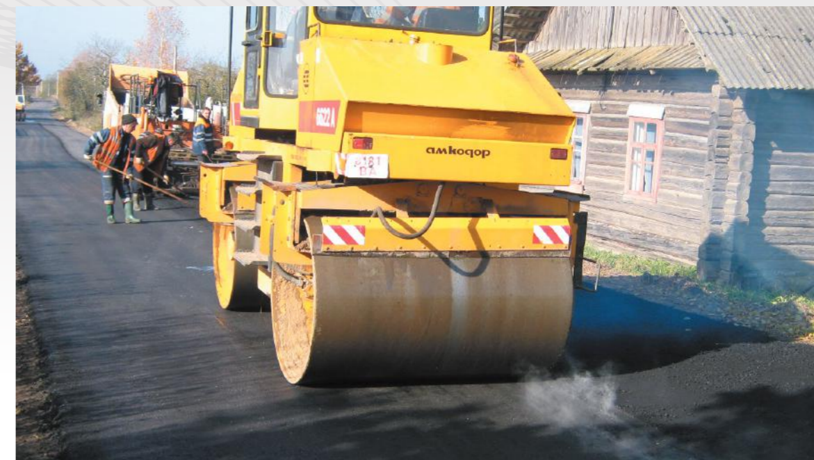
Уплотнение асфальтобетонной смеси
