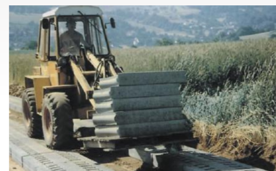
Устройство колеяных сборных покрытий
