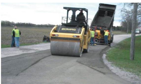
Устройство покрытий из укатываемого бетона
