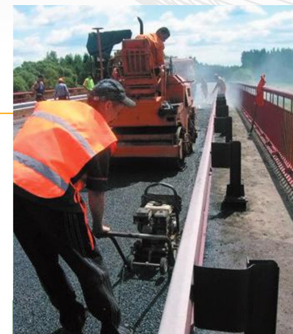
Уплотнение асфальтобетонной смеси
