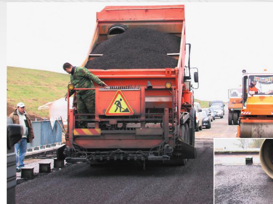
Распределение обработанного вяжущим щебня фракции от 5 до 10 мм и его последующее втапливание с помощью гладковальцового катка
