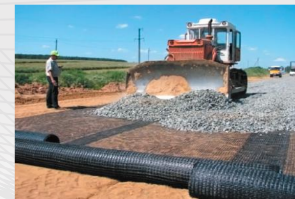
Устройство щебеночного основания
