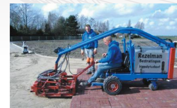
Устройство покрытий из плит тротуарных
