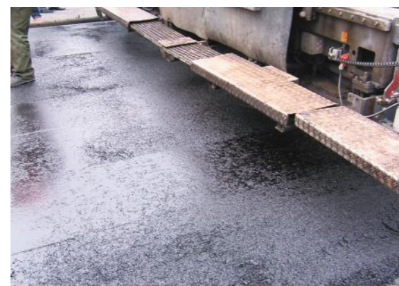
Укладка жесткой вибролитой асфальтобетонной смеси
