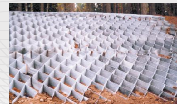
Укрепление откоса насыпи объемной георешеткой (МКАД, урочище Куропаты)
