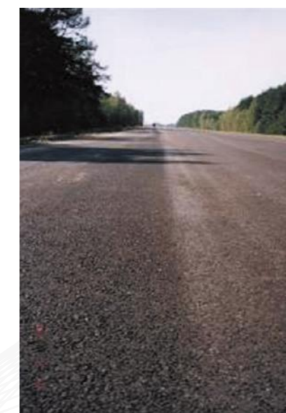
Сопряжение смежных полос с применением ленты
