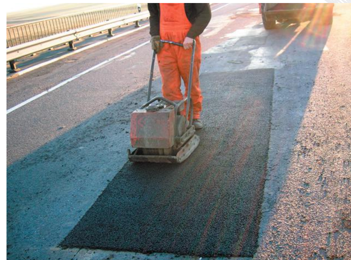
Уплотнение смеси виброплитой
