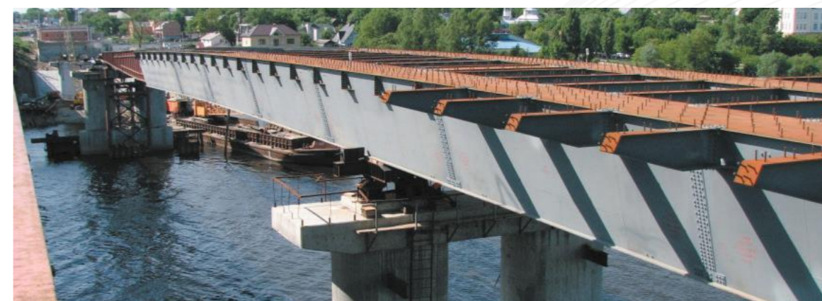
Надвижка пролетного строения моста через р. Сож, г. Гомель
