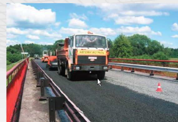
Мембранный слой с технологическим слоем щебня фракции 10–15 мм
