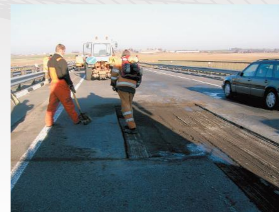
Подготовка ремонтной «карты»
