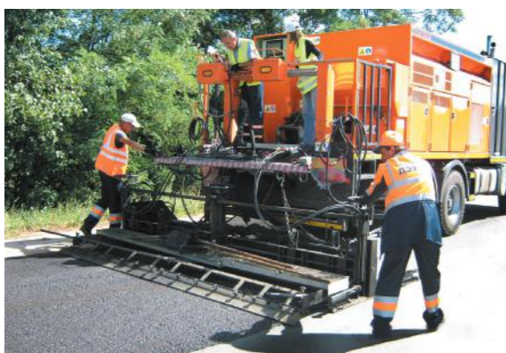
Устройство защитных слоев «Сларри Сил»
