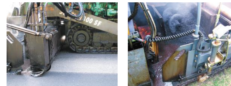
Укладка тонкого фрикционного слоя асфальтоукладчиком «Vögele Super 1800SF»
