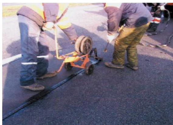
Приклеивание ленточного материала над трещиной
