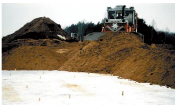
Отсыпка слоя насыпи на слабом основании (МКАД, насыпь на болоте у д. Цна)
