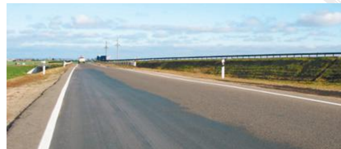
Готовое покрытие после устройства пропитки
