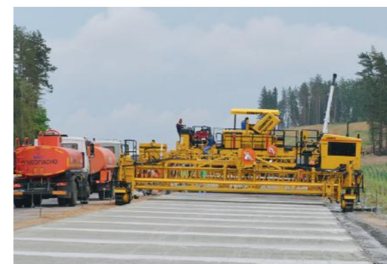
Механизм нанесения защитного слоя
