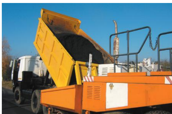
Укладка низкотемпературной асфальтобетонной смеси
