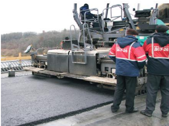
Укладка нижнего слоя покрытия из асфальтобетонной смеси с температуропонижающей добавкой
