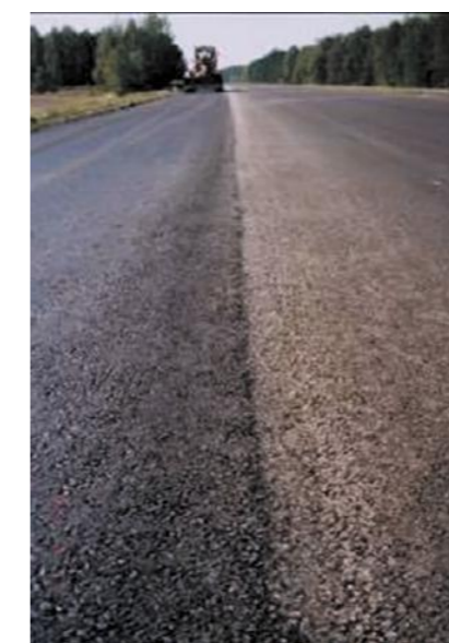
Сопряжение смежных полос без применения ленты
