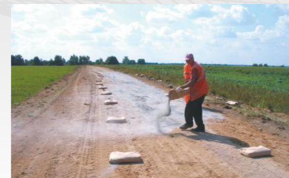
Распределение модифицирующей добавки «Nicoflok»
