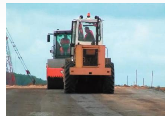
Уплотнение щебеночного основания
