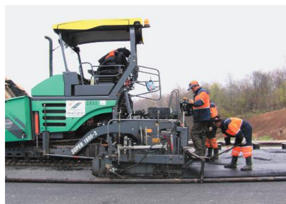
Укладка жесткой вибролитой асфальтобетонной смеси
