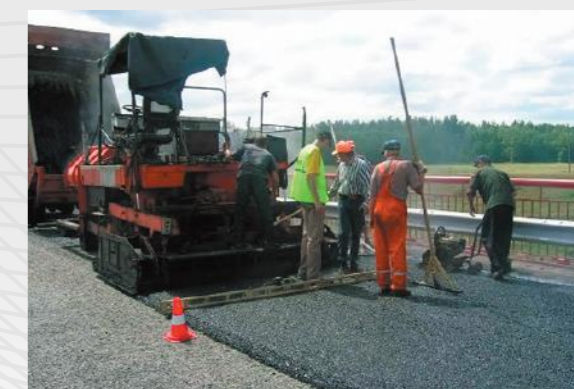
Устройство защитно-гидроизоляционного покрытия из асфальтобетонной смеси на модифицированном битуме
