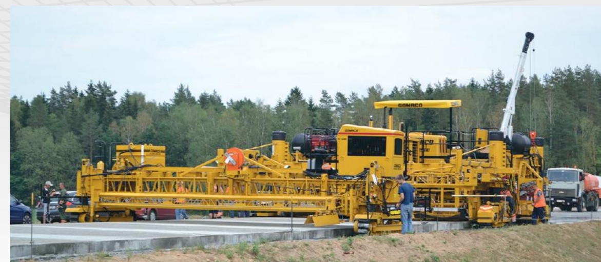
Общий вид укладки цементобетонного покрытия
