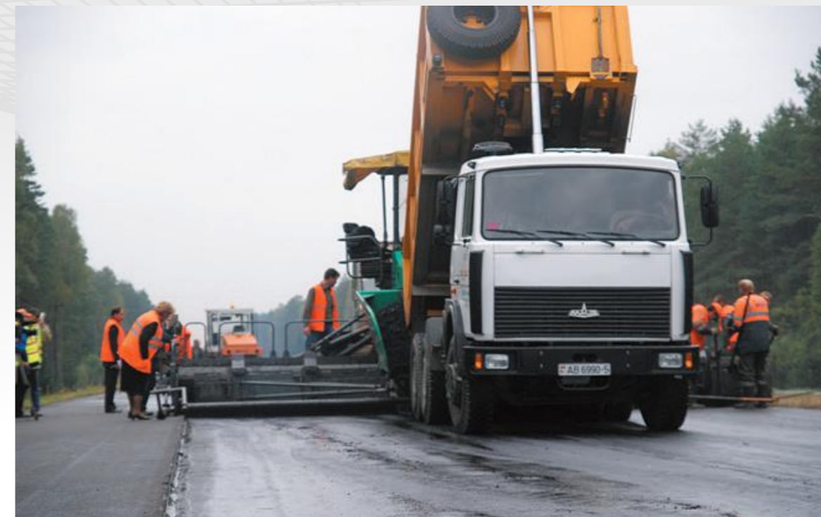
Сопряжение смежных ранее уложенной и новой полос асфальтобетонных покрытий
