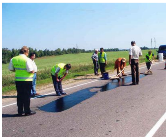
Процесс выполнения работ по пропитке асфальтобетонного покрытия
