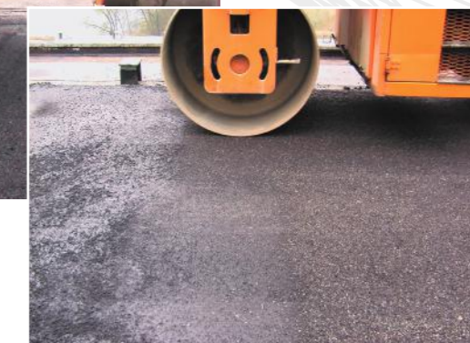
Распределение обработанного вяжущим щебня фракции от 5 до 10 мм и его последующее втапливание с помощью гладковальцового катка
