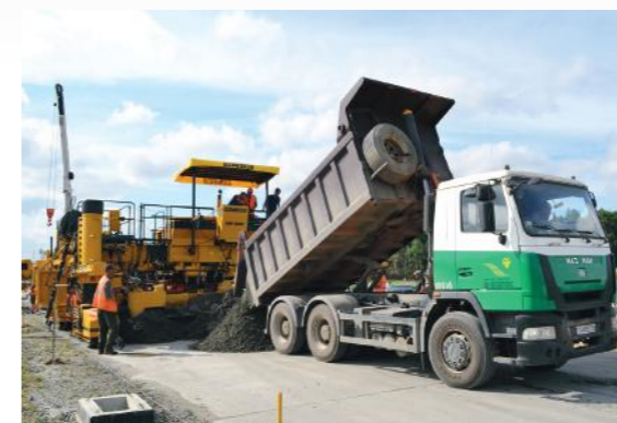
Выгрузка цементобетона из автосамосвала
