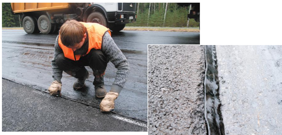
Накладка ленты к торцевой поверхности ранее уложенной полосы асфальтобетонного слоя
