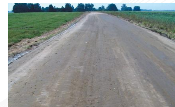
Вид устроенного укрепленного основания
