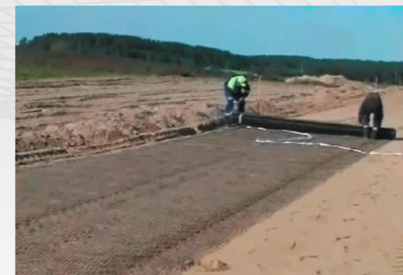
Укладка геосетки на песчаный подстилающий слой
