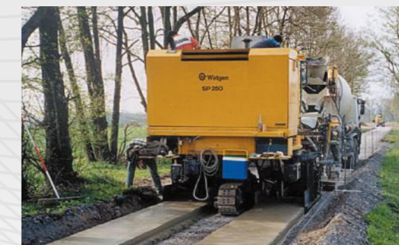
Устройство колеяных монолитных покрытий
