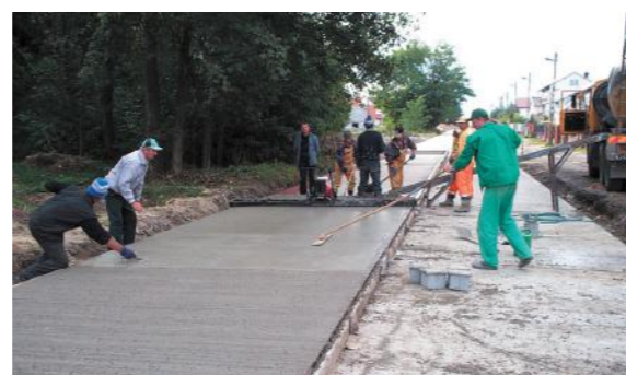
Устройство покрытий с применением несъемной опалубки
