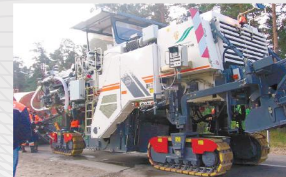
Поддача битума и воды в ресайклер Wirtgen 2200CR
