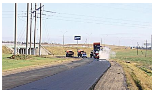
Укладка верхнего слоя покрытия из асфальтобетонной смеси с температуропонижающей добавкой
