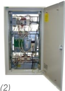
Блок управления стенда
